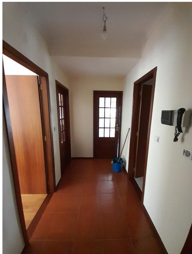
Hall – Pavimento em cerâmico em bom estado
