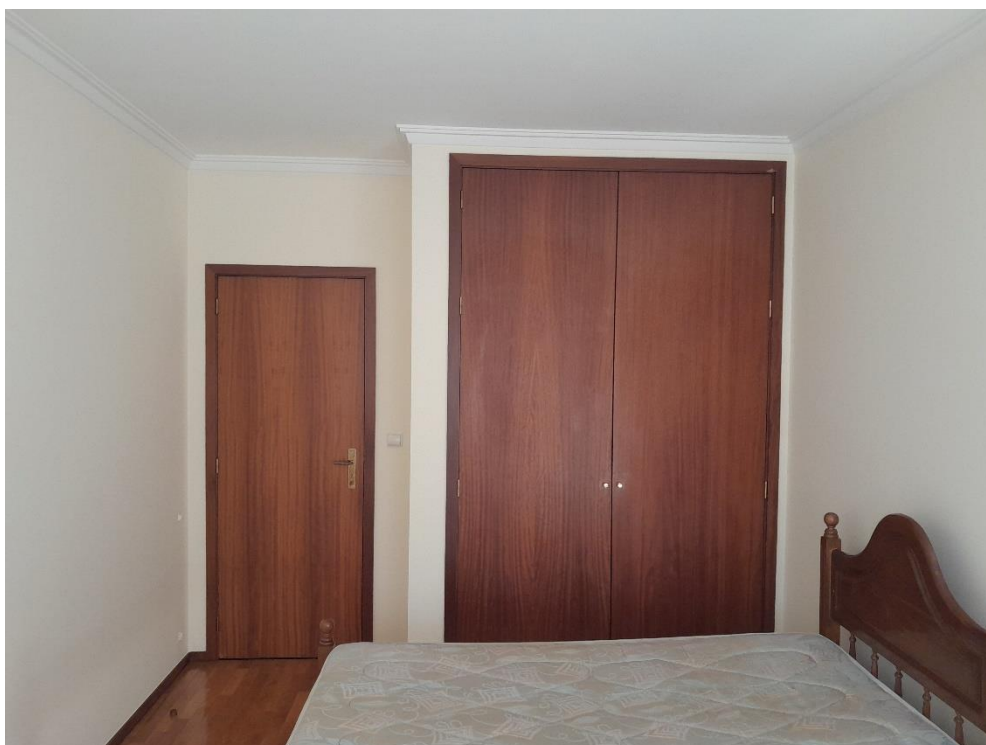
Quarto 1 – Pintura em bom estado
