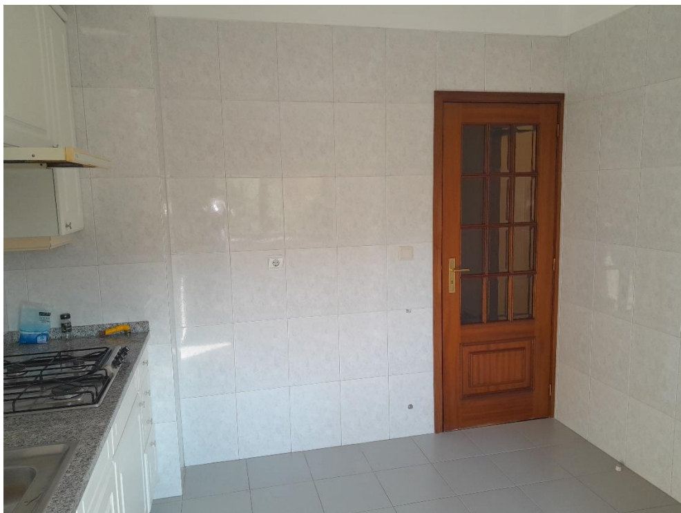
Cozinha – Paredes e pavimento revestido a cerâmica, encontrando-se em bom estado
