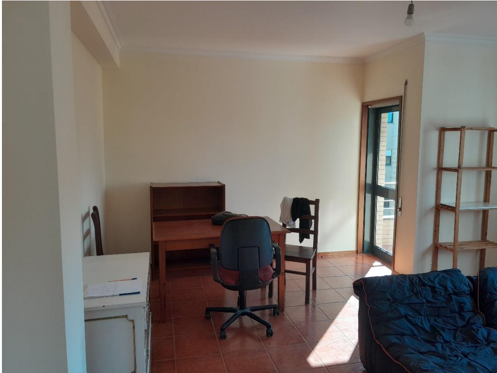
Sala – Pintura do teto bom estado
