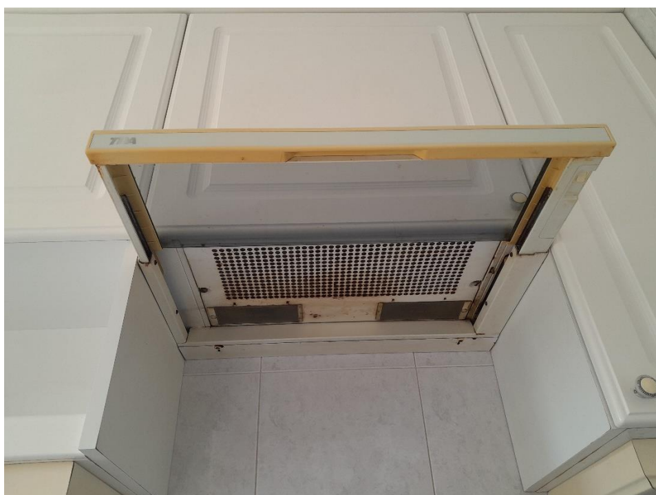
Cozinha – Mecanismo de exaustão (sem motor) com bastante uso e com sinais de oxidação
