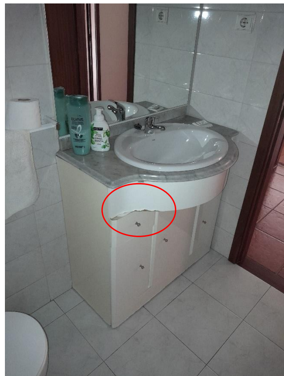
W.C. – Lavatório em estado razoável, com o armário deteriorado numa zona limitada
