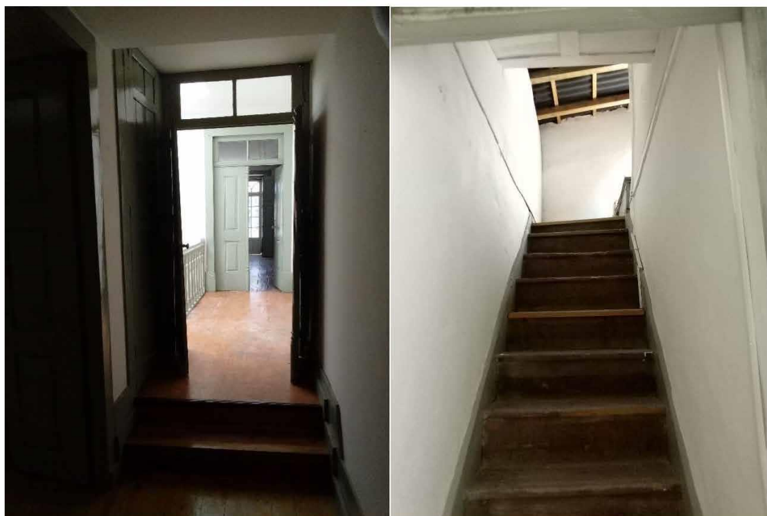
Acesso às águas furtadas
